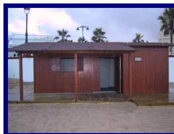
Caseta con aseo adaptado
