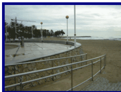
Vista de una rampa que hace accesible la entrada a la playa
