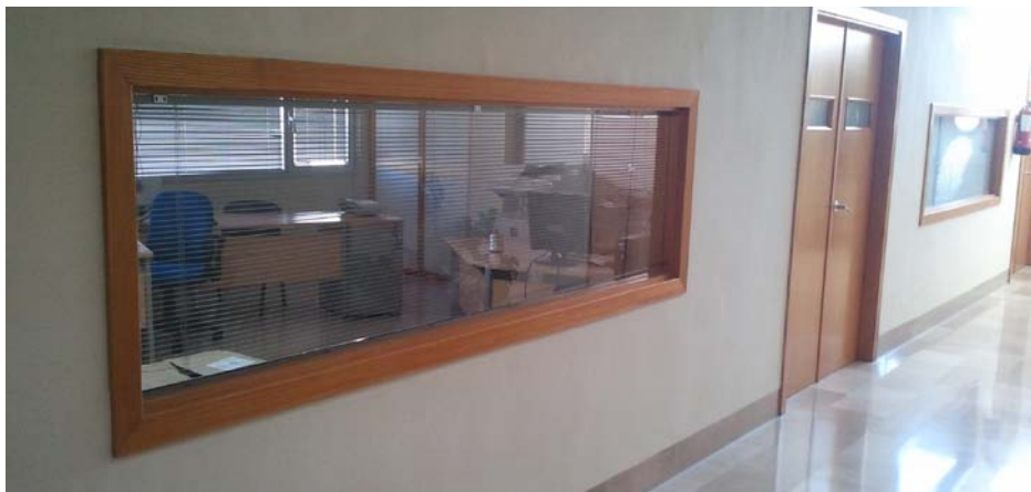
Imagen 15. Colocación de vidrios en tabiquerías. Sede de la Fundación Andaluza Accesibilidad y Personas Sordas de Granada. / Elaboración propia.
