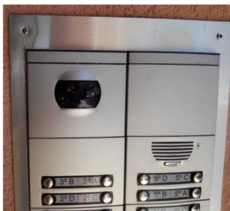
Imágenes 21 y 22. Videoportero con cámara que permite la visualización desde el interior pero no desde el exterior. / Elaboración propia.
