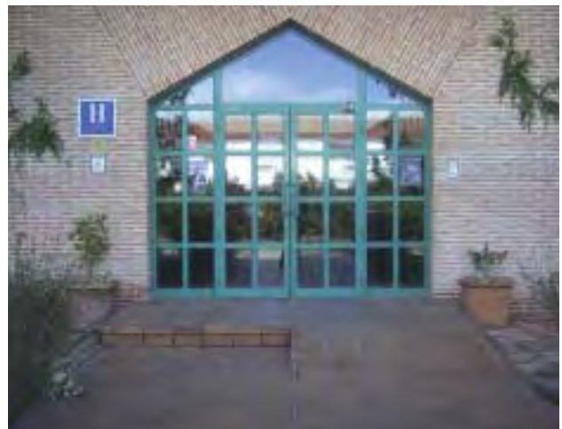
Ejemplo de escalón de acceso a Hotel salvado mediante rampa. Sería conveniente instalar en la rampa un doble pasamanos a ambos lados
