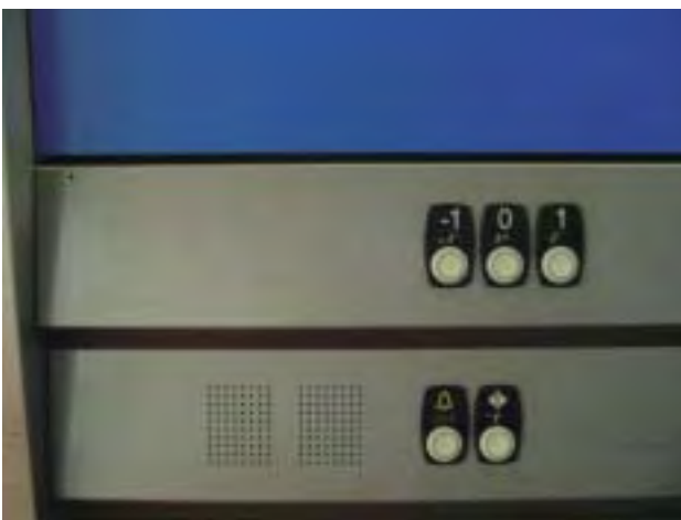
Ejemplo de botonera de cabina de ascensor, números en color contrastado, braille y altorrelieve
