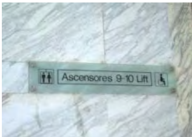
Contraste cromático entre figura y fondo, pero carencia de contraste entre soporte y pared
