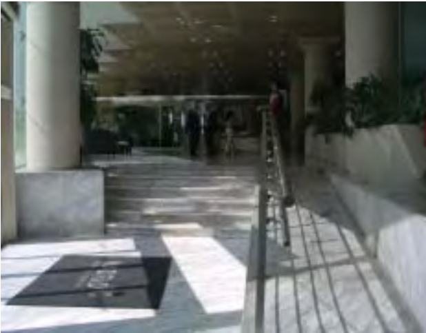
Ejemplo de rampa con pavimento antideslizante y no señalizada en el área de embarque y desembarque
