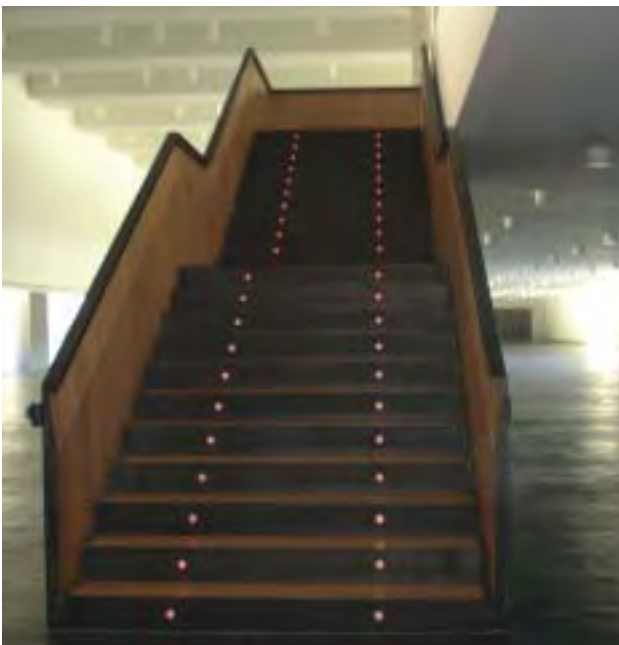
Ejemplo de buena práctica en accesibilidad, huella y contrahuella de colores contrastado. La señalización de uno y otro peldaño ha sido reforzada con los puntos de luz de la tabica.
