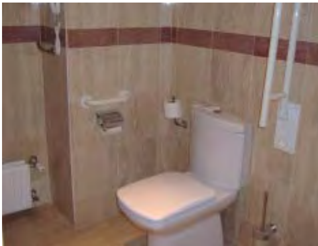
Ejemplo de inodoro con espacio lateral de transferencia en un lado. Barra fija en el lado de la pared y abatible en el lado de la transferencia
