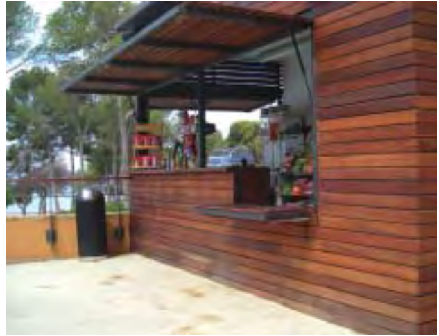
Ejemplo de barra a doble altura y con espacio de aproximación frontal para persona en silla de ruedas
